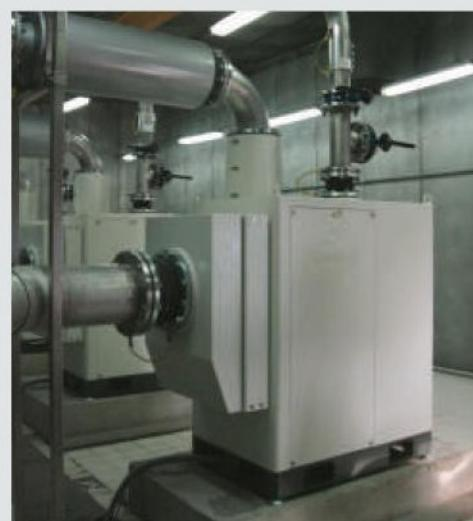
Версия с фланцем для присоединения трубопровода со стороны всасывания.
